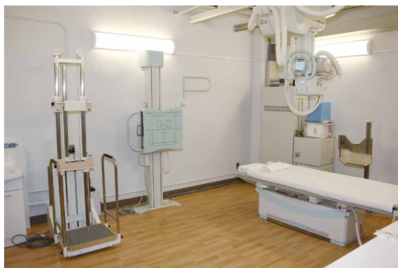
第一骨撮影室
